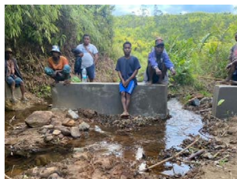
Travaux d'irrigation © IMPACT Madagascar
