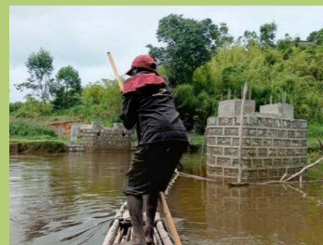
Passerelle en construction © IMPACT Madagascar
